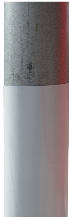
Folie schützt Fallrohr (z. B. bei Putzarbeiten)
