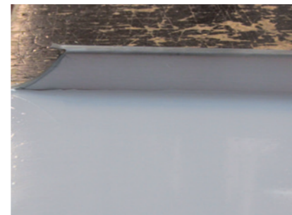
Beklebte Schare bei einer Doppelstehfalzdeckung
